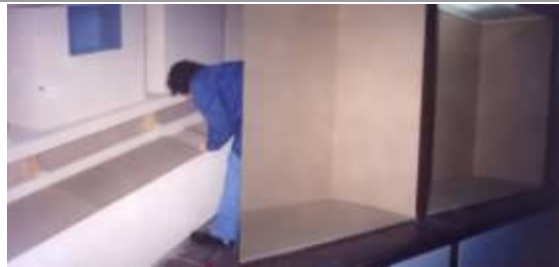
Fig. 5: Izq. Montaje de vitrina horizontal diseñada para el objeto a exponer (Fósiles) Der. Vitrinas existentes ya revestidas e iluminada.
